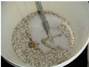
Bindemittel in den Kübel/Eimer mit Steinen geben und gründlich durchmischen, bis alle Steine mit dem Bindemittel benetzt sind.
