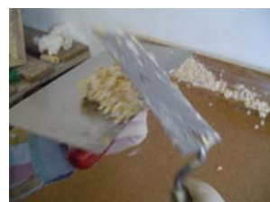
Kelle gleichmäßig mit Stein-Gemisch belegen und auf die Klebeschicht drücken und verspachteln
