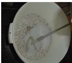
3. Mit ca. 1 Drittel des thixotropierten Bindemittels Vertical A+TX Klebefilm auf Sockel streichen 4. Angemischte Steine auf vorher aufgetragenen Klebefilm „nass in nass“ aufspachteln.
