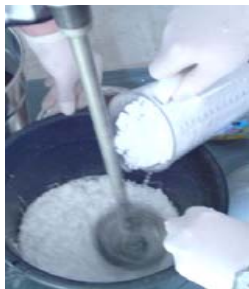
1. Thixotropiermittel in Bindemittel einmischen 2. Zwei Drittel des thixotropierten Bindemittels Vertical A+TX in ca. 8 kg Steine einmischen
